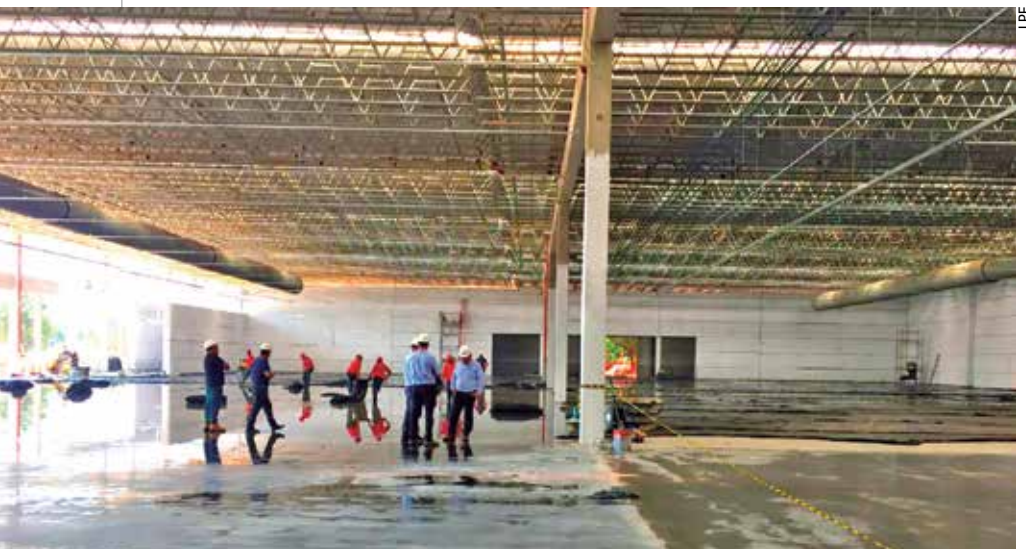
▲ Piso de concreto reforçado com fibras de aço e juntas metálicas viabilizou a instalação da nova loja da Sodimac
